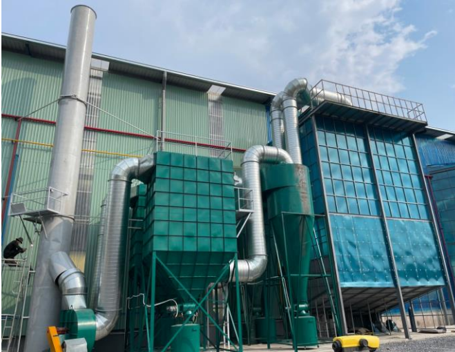
Hình 3.7. Hệ thống xử lý bụi bề mạ kẽm
