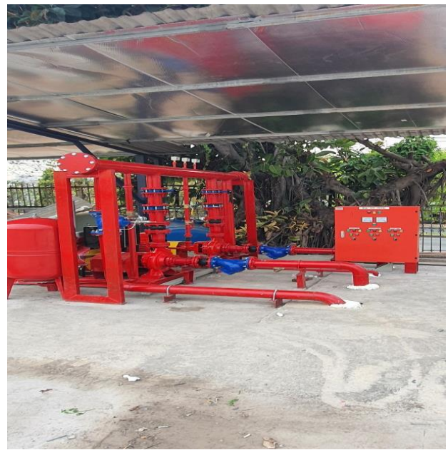
Hình 3.11. Hình ảnh hệ thống PCCC đã được lắp đặt tại Công ty
