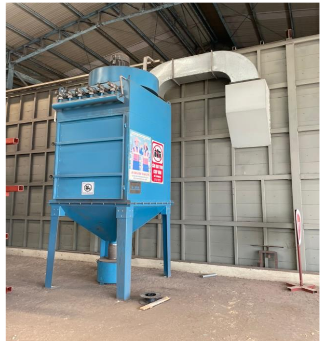
Hình 3.8. Hình ảnh hệ thống xử lý bụi từ công đoạn phun bi
