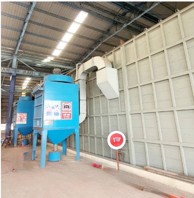
Hình 3.8. Hình ảnh hệ thống xử lý bụi từ công đoạn phun bi
